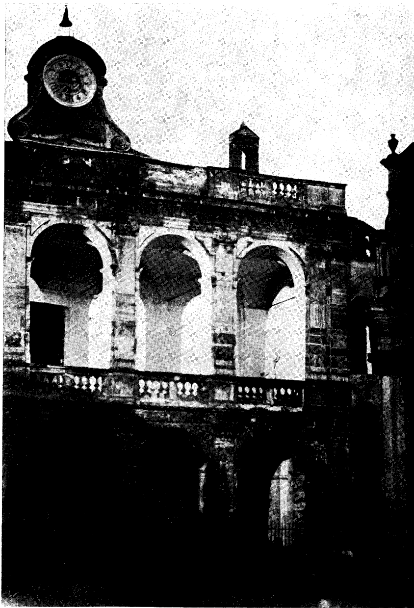
Facciata del palazzo Camuccini a Cantalupo Sabino.
